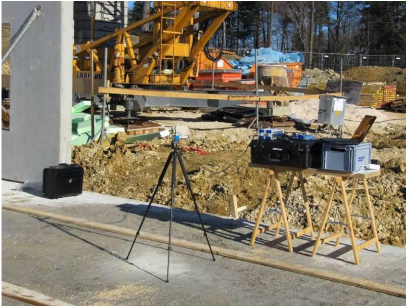
Bild 11 Mobiles Magnetfeldmesssystem auf der Baustelle
