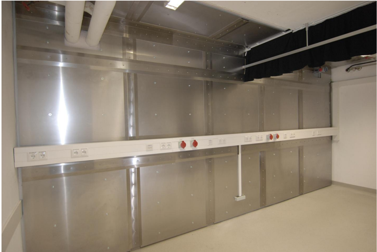
Bild 6 Schirmung eines physikalisch-technischen Labors mit MAGSS
